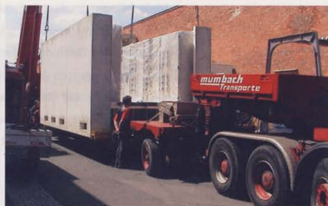
Bild 3: Transport der Betongebäude mitsamt der Schaltanlagen
