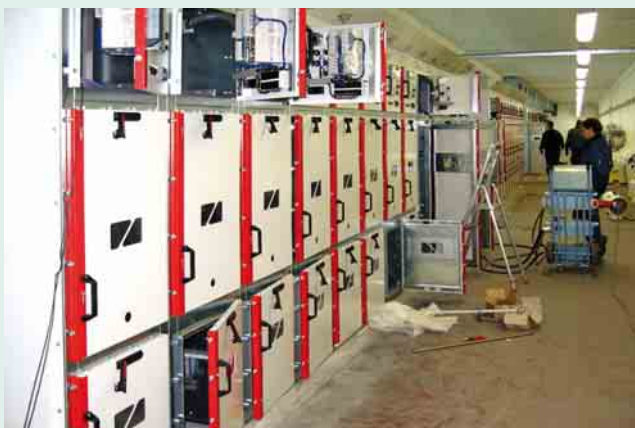
3 Montage der Schaltfelder
